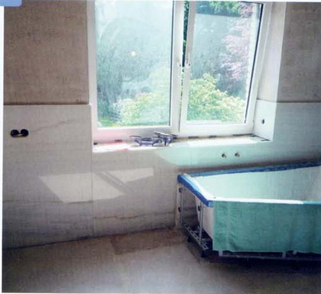
Der Bodenbelag ist bis unter die aufgestellte Wanne gezogen, um Anschnitte an den Platten zu vermeiden.
