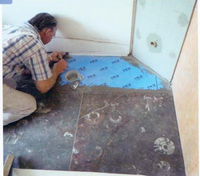
Eine selbstklebende Verbundabdichtung verhindert die Durchfeuchtung; auch im Wandbereich wurde eine Dichtungsbahn angebracht.
