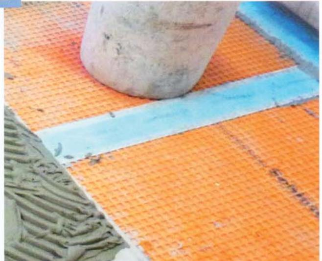
... die Stoßfugen werden mit einem selbstklebenden Dichtband überarbeitet.
