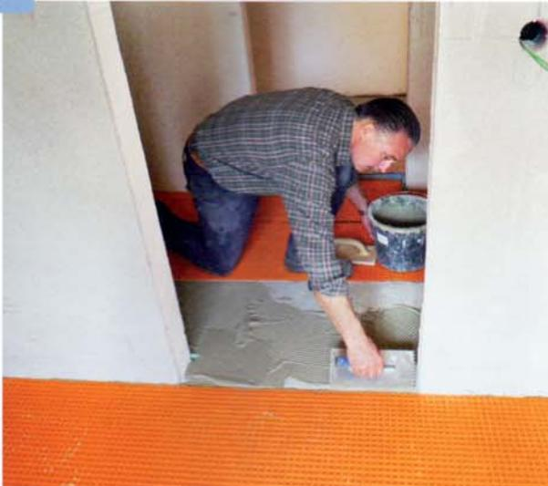
Die Verbundabdichtungsbahn wird mit einem auf den Untergrund abgestimmten Dünnbettmörtel verklebt und ...
