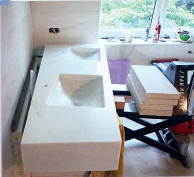
Mit dem Hubwagen wird das 420 kg schwere Werkstück in Position gebracht und montiert.
