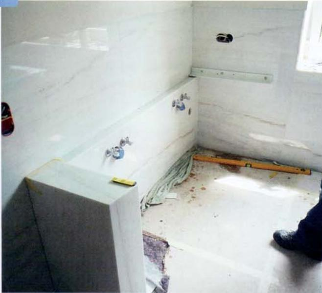
Ein seitlicher Pfeiler und eine Wandkonsole tragen den aus einem Block gearbeiteten Waschtisch.
