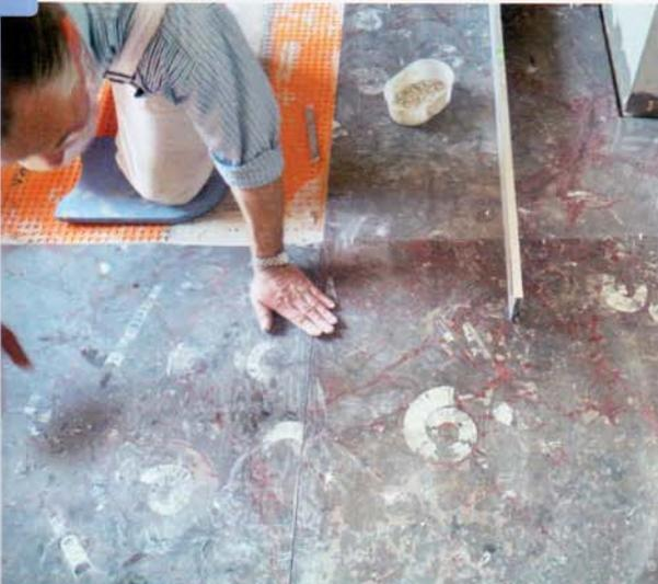
Der Ansetzmörtel ist speziell für die Verlegung von Naturwerkstein im Mittelbettverfahren konzipiert.
